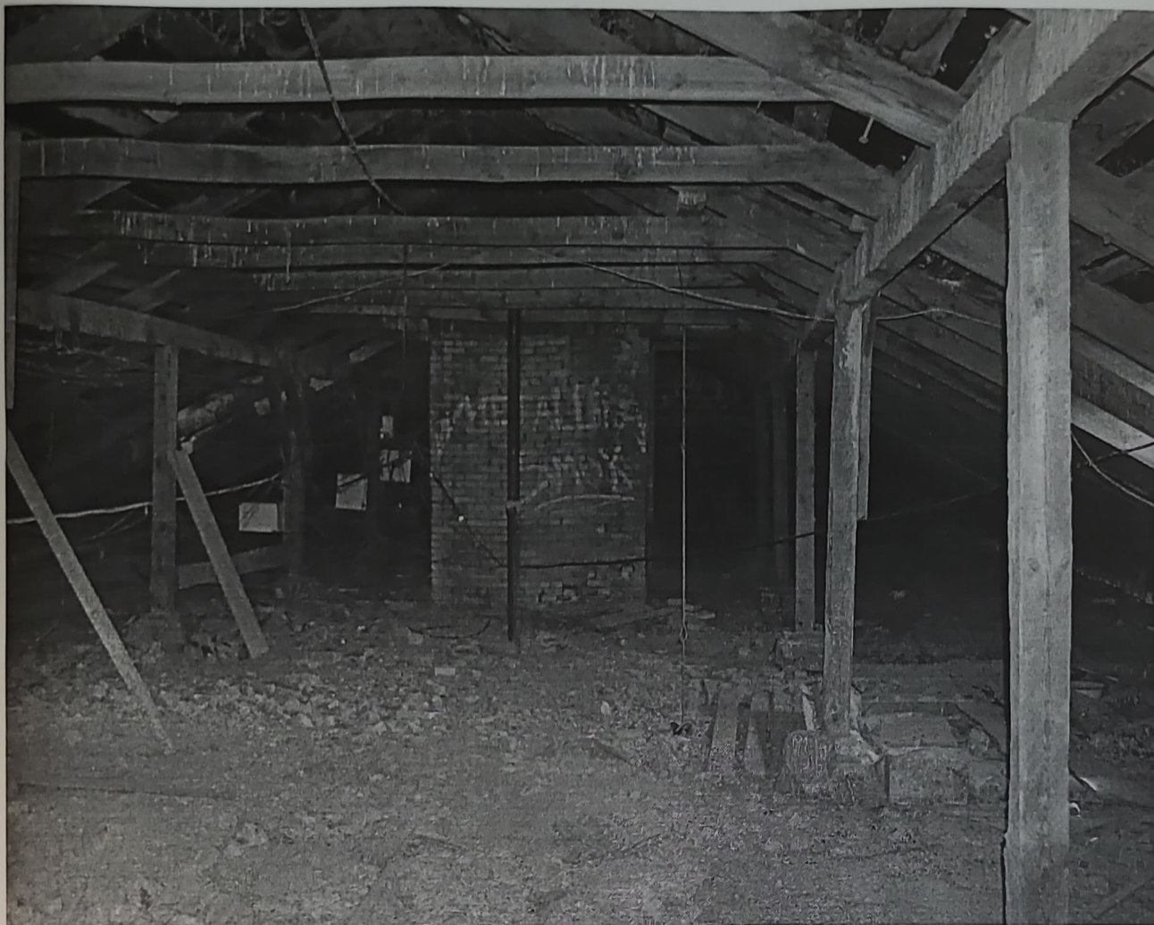
Фото 3. Общий вид чердачного помещения.
