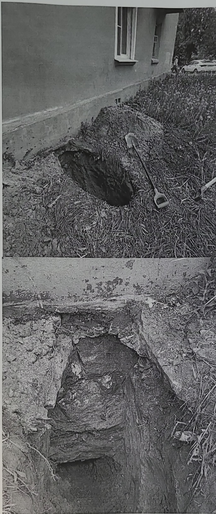
Фото 8. Общий вид шурфа №1
