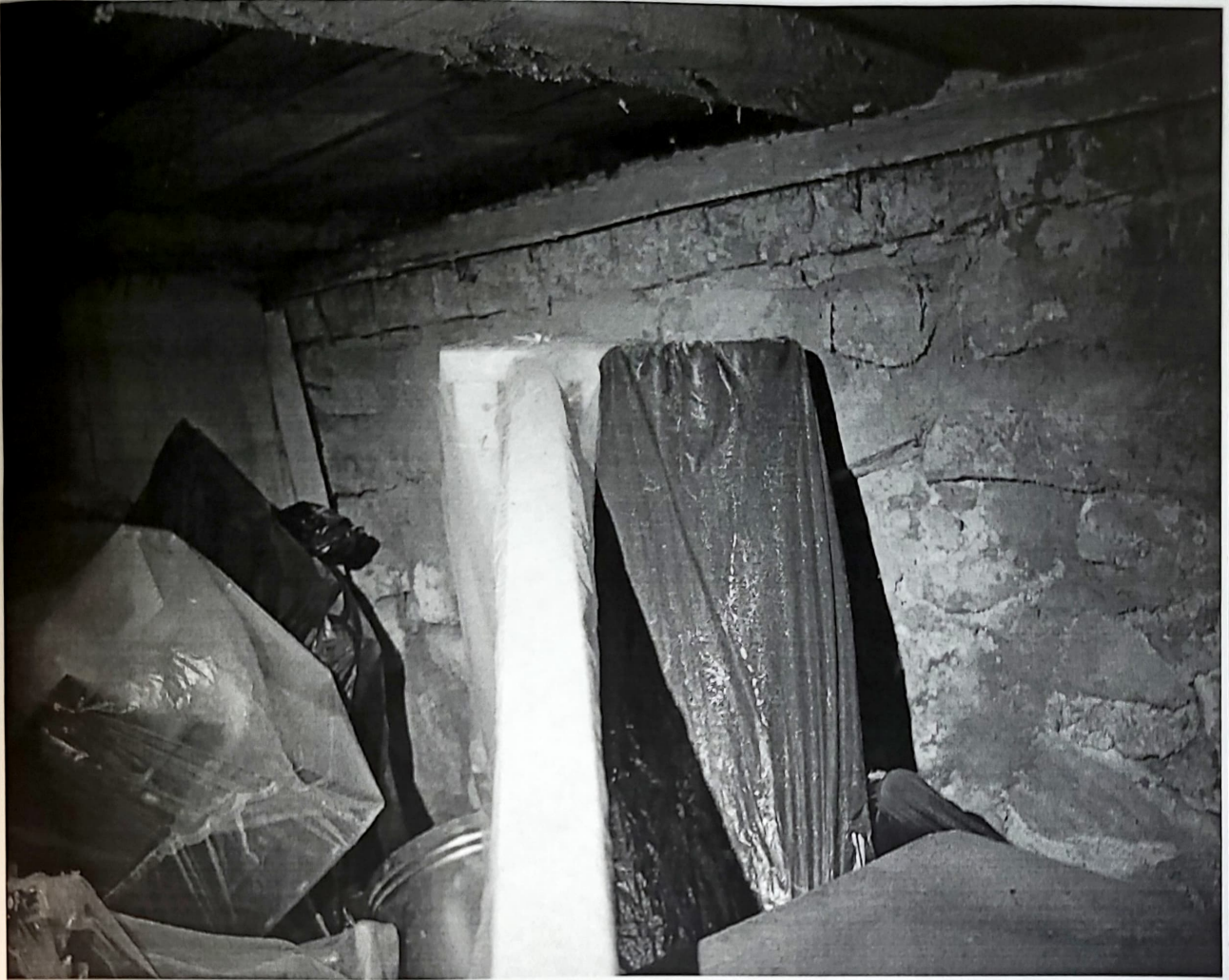
Фото 5. Общий вид приямка.
