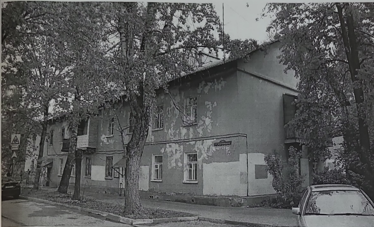
Фото 1. Общий вид обследуемого здания.
